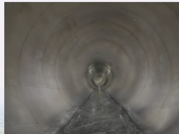
รูปแสดง ตัวอย่างอุโมงค์ที่ก่อสร้างจริง
