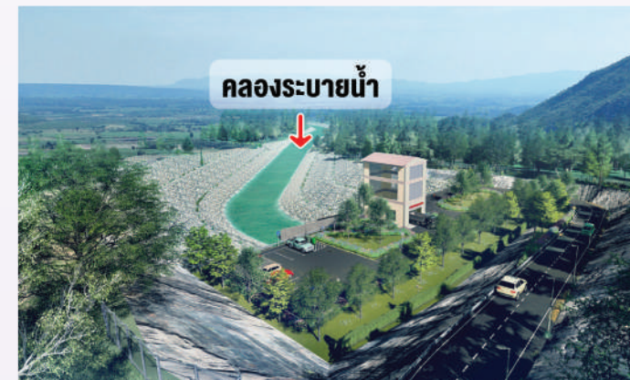
รูปแสดง ภาพจำลองบริเวณอาคารประกอบห้วงงานปลายอุโมงค์ อาคารจ่ายน้ำ คลองระบายน้ำลงอ่างเก็บน้ำลำอิฐ
