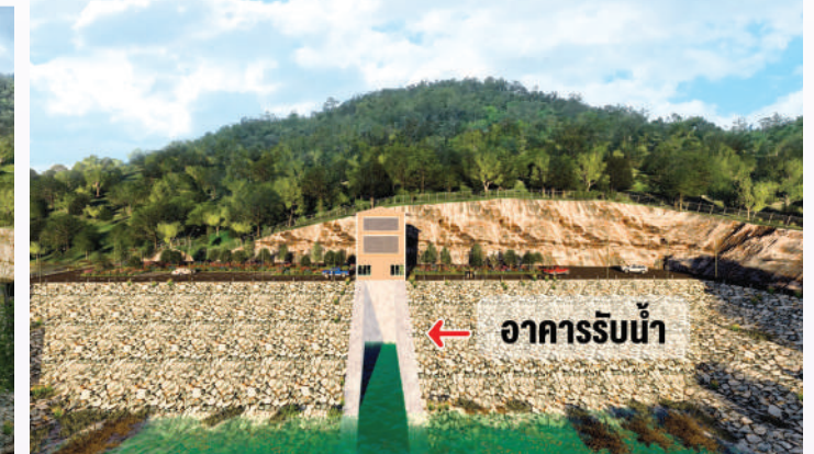
รูปแสดง ภาพจำลองบริเวณอาคารประกอบห้วงงานปากอุโมงค์ อาคารรับน้ำ คลองชักน้ำ ในอ่างเก็บน้ำเขื่อนศรีนครินทร์
