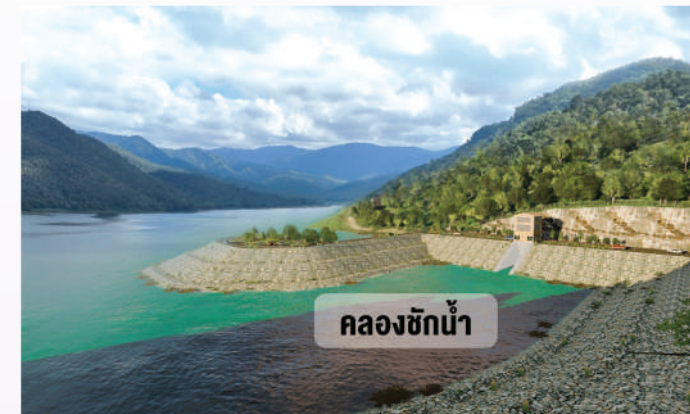
รูปแสดง ภาพจำลองบริเวณอาคารประกอบห้วงงานปากอุโมงค์ อาคารรับน้ำ คลองชักน้ำ ในอ่างเก็บน้ำเขื่อนศรีนครินทร์
