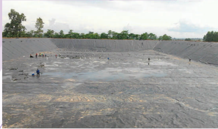
รูปแสดง วิธีการก่อสร้างบ่อกักน้ำหลุมรัง
