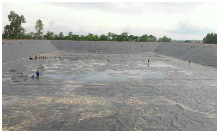
รูปที่ 11 แสดงวิธีการก่อสร้างบ่อบักน้ำหลุมรัง
