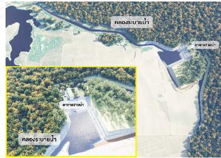
รูปที่ 8 แสดงภาพจำลองบริเวณอาคารประกอบห้วงงานปลายอุโมงค์ อาคารจ่ายน้ำ คลองระบายน้ำลงอ่างเก็บน้ำลำอิฐ
