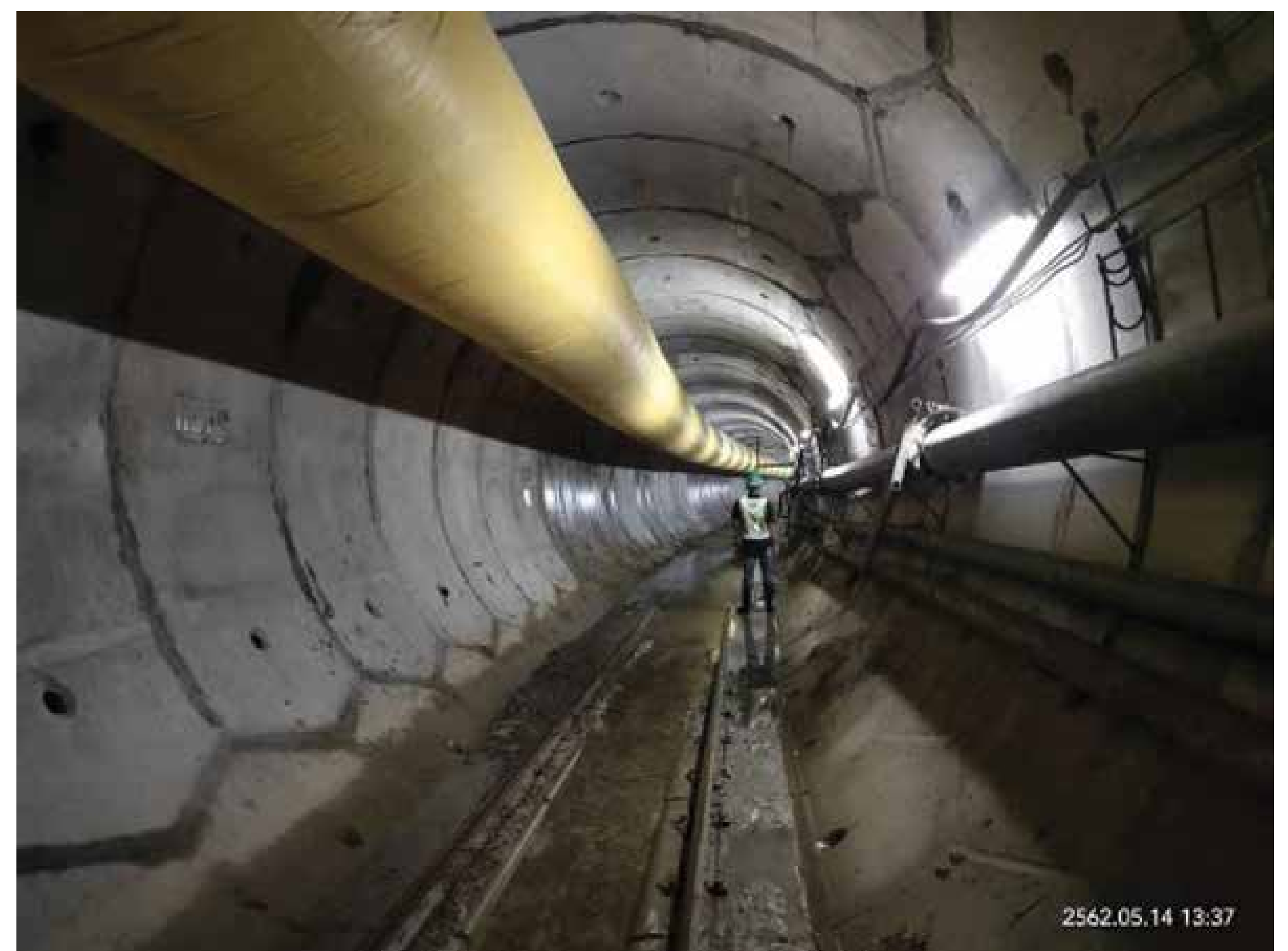
ตัวอย่างอุโมงค์ที่กำลังสร้างจริง
