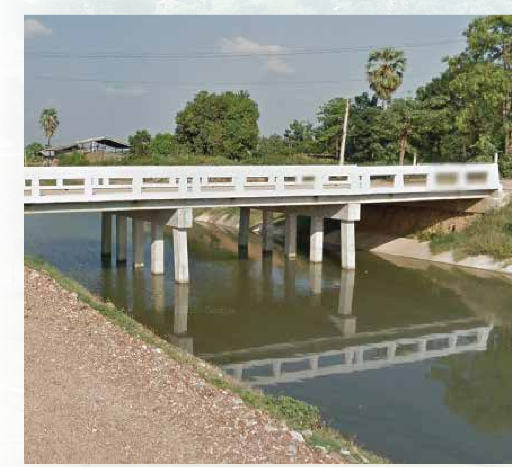
สะพานรถยนต์ข้ามคลอง
