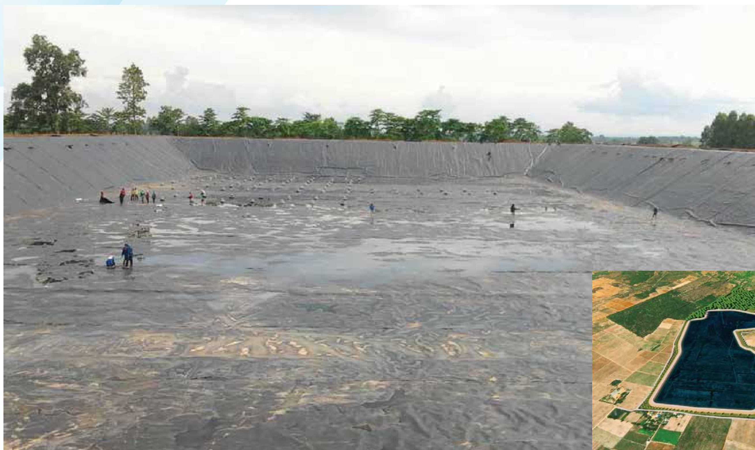
วิธีการก่อสร้างบ่อพักน้ำหลุมรัง
